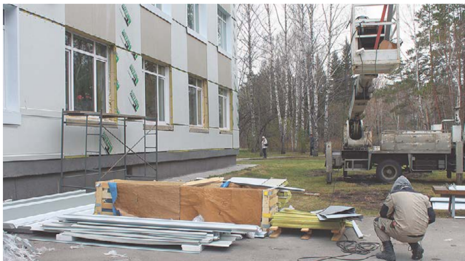
Монтаж фасада Института теплофизики СО РАН
