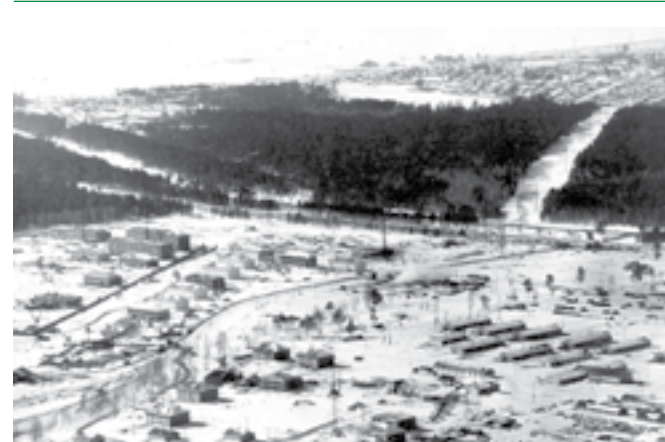
Микрорайон «Щ» в начале строительства. 1961 г.
