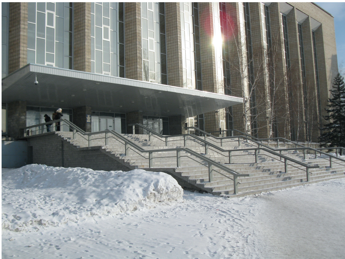
Рис. 8. Вид на парадный вход ГПНТБ СО РАН после капитального ремонта
