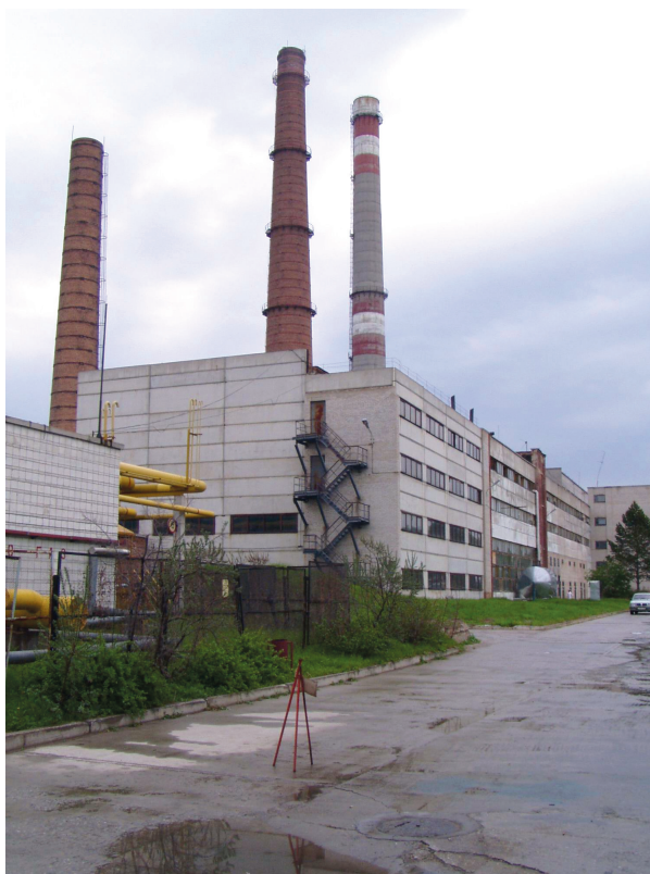
Рис. 19. Тепловая станция № 2 ГУП «УЭВ СО РАН»
