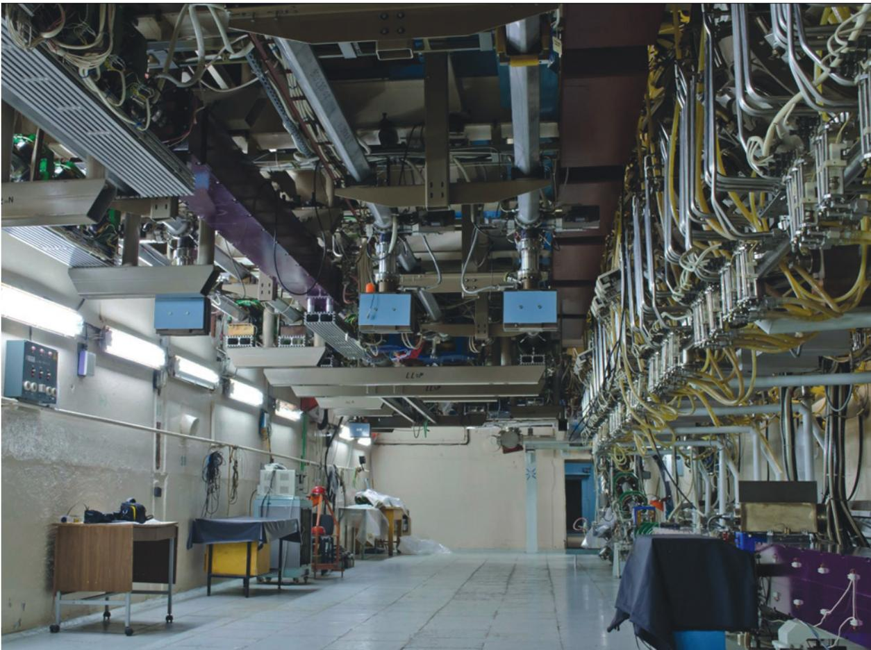
**Рис. 53.** Ускорительный зал с размещенным на потолке ускорителем-рекуператором.
