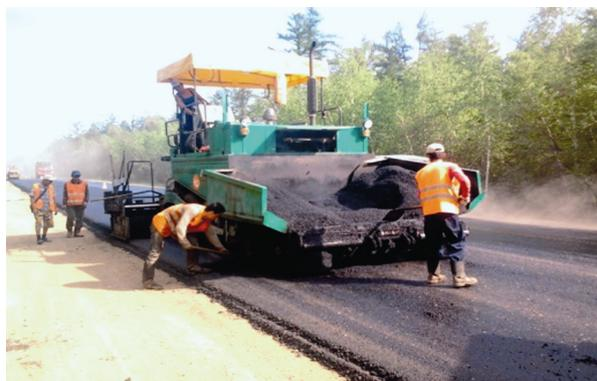
**Рис. 26.** Укладка покрытия дороги асфальтобетонной смесью, разработанной ИПНГ, июль 2012 г.
